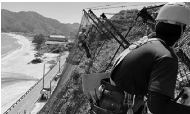
ロックネットによる法面の保護（陸上地内）
