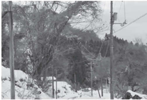
倒れる前に対処したい(鳥越地内の危険木)
