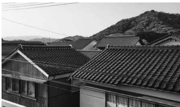
災害に備え耐風診断・改修を進める
