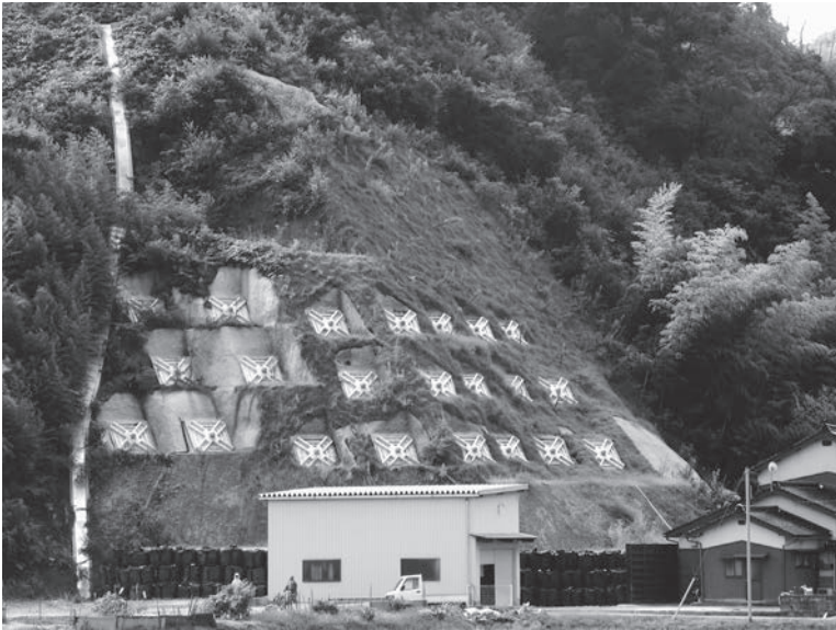
進行中の治山工事
