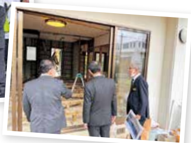
改修中の住宅を視察
