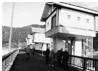
足羽川頭首工は、約2000haの農地に水を送っています
