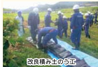
土のうづくり
