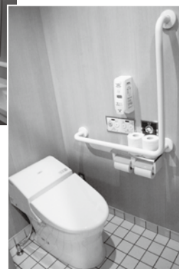
個室トイレ内
