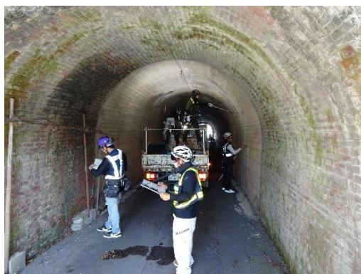
写真2.1 点検状況写真（トンネル定期点検）
