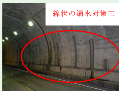
写真2.4 線状の漏水対策工の事例
