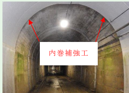
写真2.2 内巻補強工の事例
