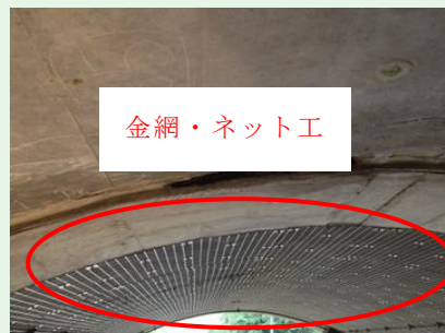
写真2.3 金網・ネット工の事例
