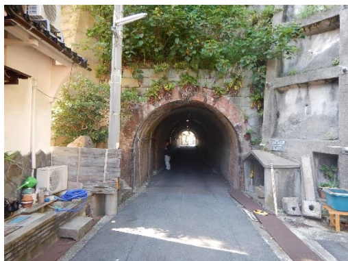
写真3.1 網代トンネル状況写真
