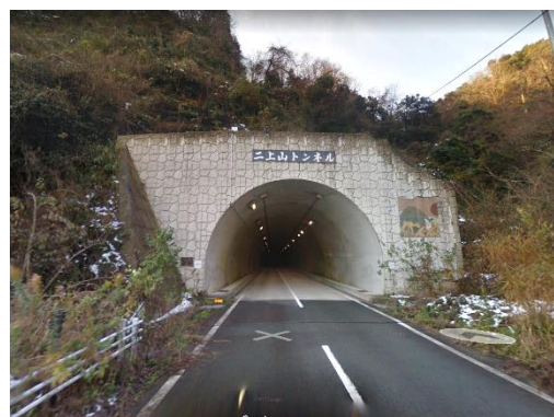
写真3.2 二上山トンネル状況写真
