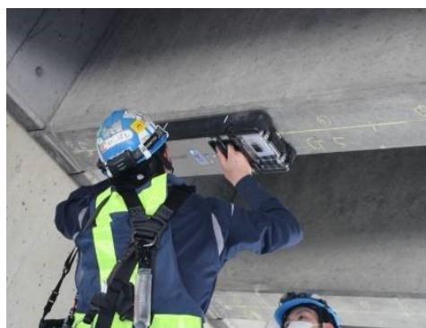
非破壊検査技術を使用した点検
