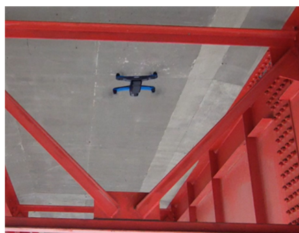
ドローンによる点検
