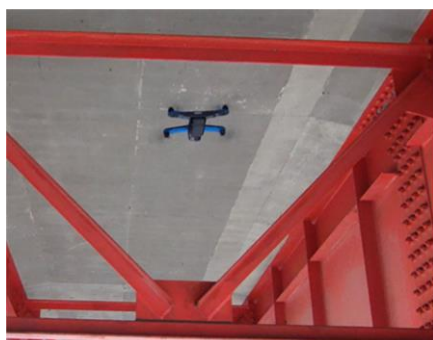
ドローンによる点検
