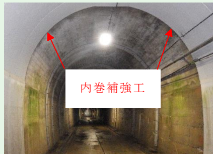
写真2.2 内巻補強工の事例
