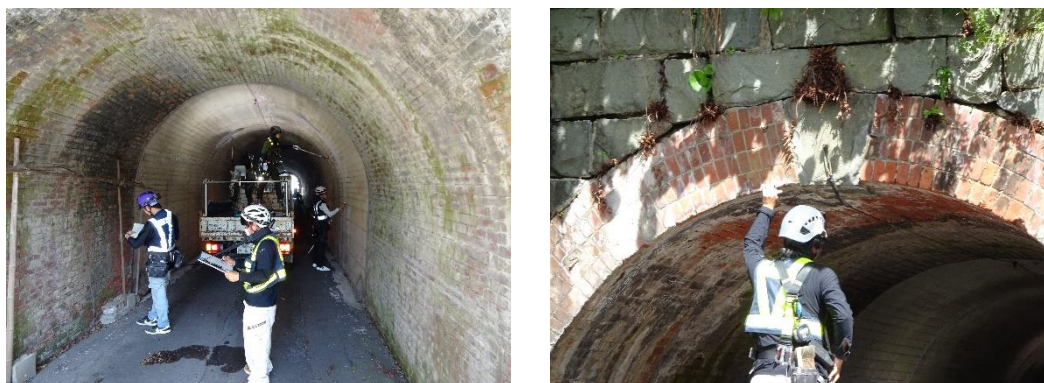
写真2.1 点検状況写真（トンネル定期点検）
