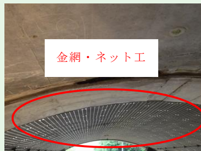
写真2.3 金網・ネット工の事例
