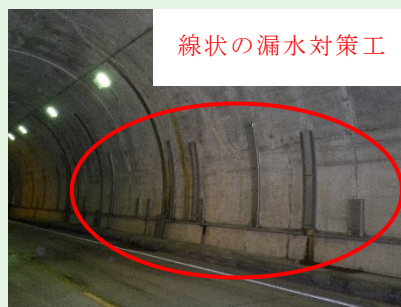
写真2.4 線状の漏水対策工の事例
