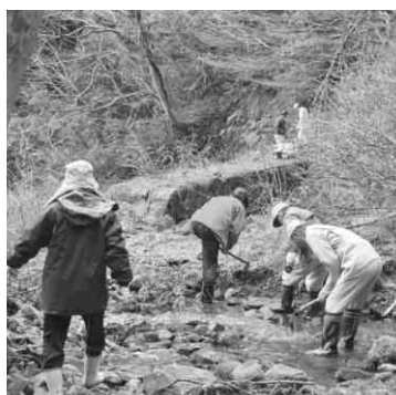
歩道整備事業、作業風景
