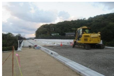
令和7年11月 橋接続西側工事
