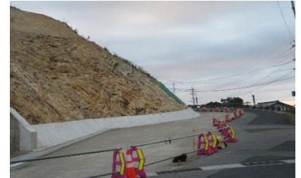
令和4年11月 西側山切り工事後
