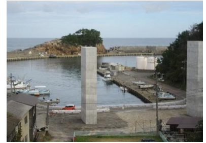
令和3年11月 西側橋脚工事完成後
