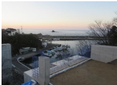
令和5年2月 東側橋台工事
