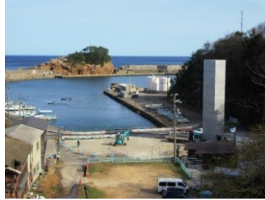
令和3年3月 東側橋脚工事完成後
