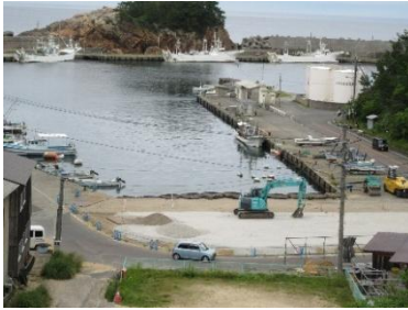
令和2年6月 橋脚工事開始前
