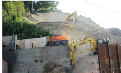
令和4年7月 西側山切り工事
