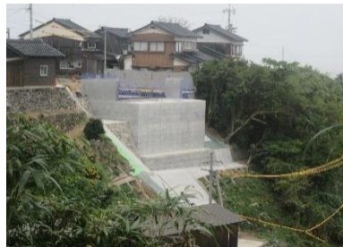
令和5年11月 西側橋台完成
