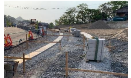
令和8年5月 東側歩道・側溝工事
