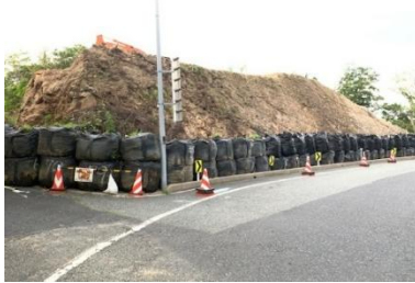
令和3年5月 東側山切り工事
