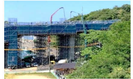
令和6年6月 橋梁上部（コンクリート打設）工事
