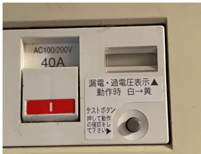
高山団地(5～7号) 既存分電盤 平成16年度 建設時からの製品
