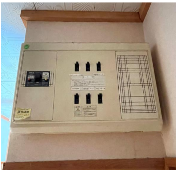
上津エロ団地 既存分電盤 平成8年度 建設時からの製品
