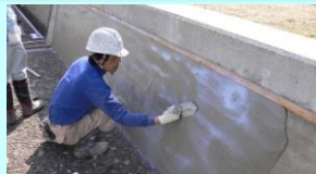
老朽化した水路壁のコーティング
