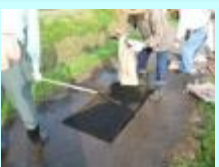
農道の部分補修
