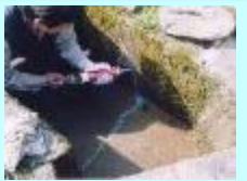
水路のひび割れ補修
