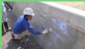
老朽化した水路壁のコーティング
