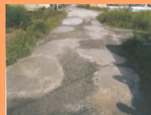
農道の窪みの補修
