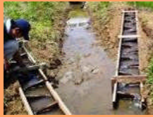
水田魚道の設置
