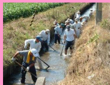
水路の泥上げ
