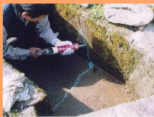
水路のひび割れ補修
