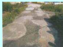
農道の窪みの補修
