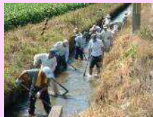
水路の泥上げ
