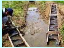
水田魚道の設置
