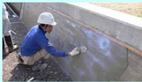
老朽化した水路壁のコーティング
