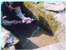
水路のひび割れ補修
