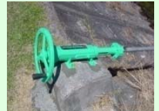
ゲート、バルブの更新
