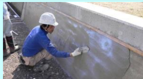
老朽化した水路壁のコーティング
