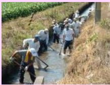
水路の泥上げ
