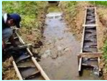
水田魚道の設置
