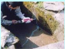
水路のひび割れ補修
