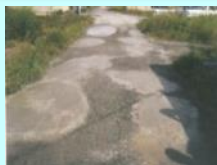
農道の窪みの補修
