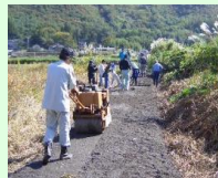
未舗装農道の舗装
