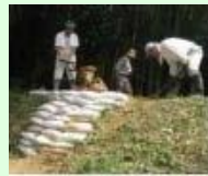
漏水箇所の補修
