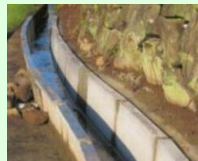
コンクリート水路の更新
