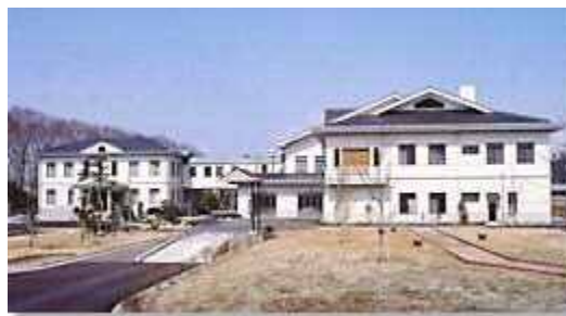
因幡浄苑の外観
