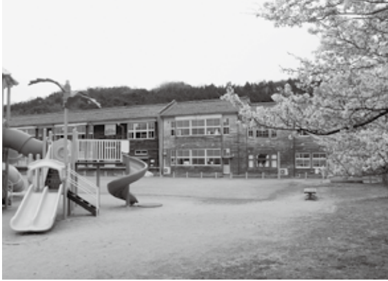
ユニバーサルデザインしごと・交流センター整備予定地（旧本庄小学校を解体）
