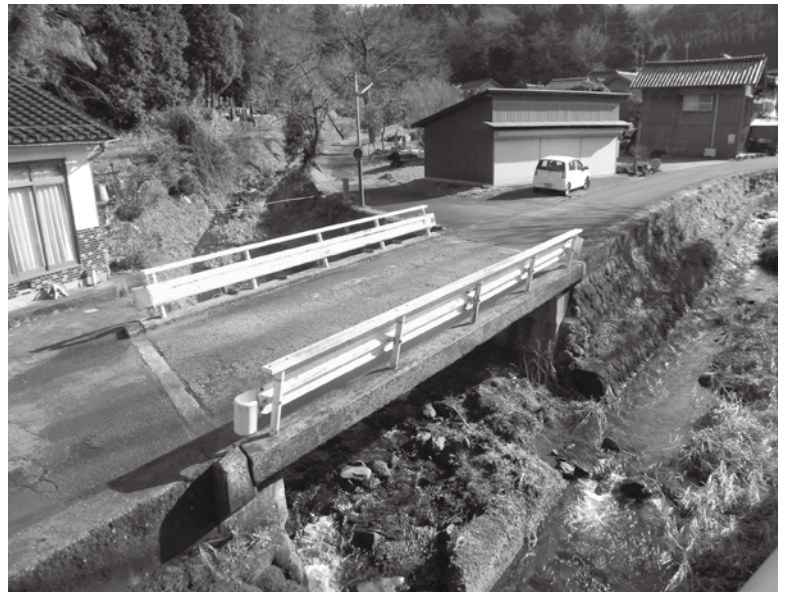
修繕予定の塩谷橋
