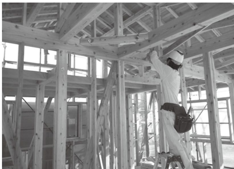
耐震金具を設置している住宅
