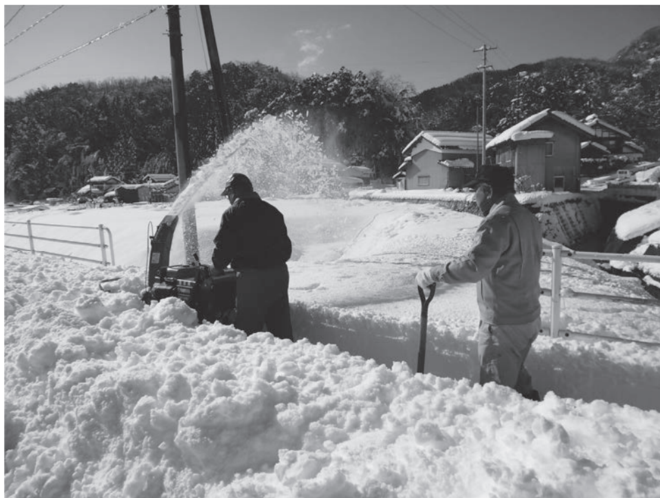
歩道の除雪作業（長郷）
