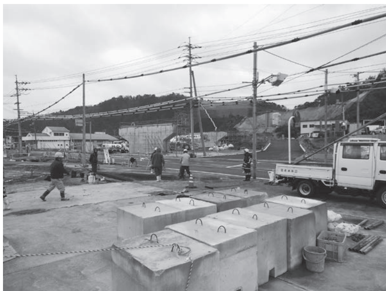
工事が進む浦富インターチェンジ付近
