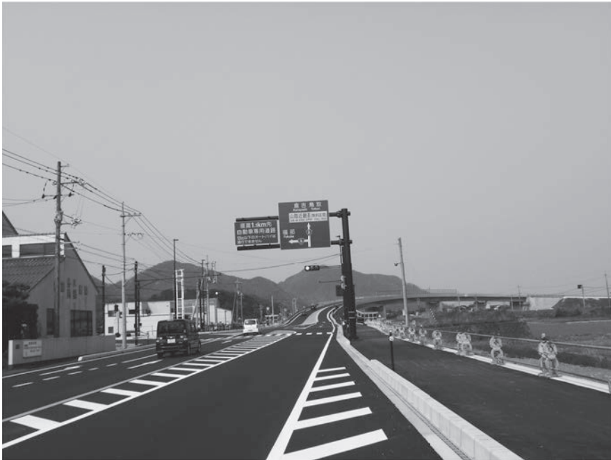
駒馳山バイパス進入路
