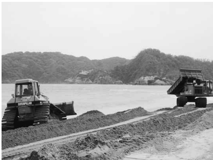
侵食・堆積対策（浦富海水浴場）
