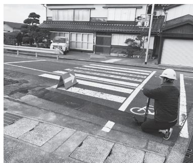
水道管耐震化のための敷設替え工事に伴って仕切弁を操作する町職員
