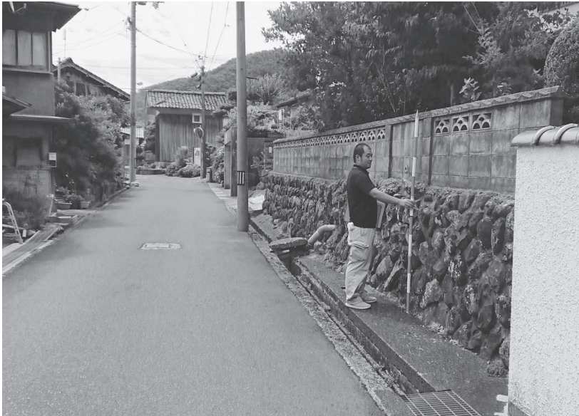
大阪北部地震の塀倒壊事故を受け通学路のブロック塀を調査
