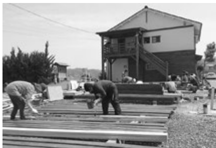
空き家をコミュニティカフェに改修する若者たち（浦富地区）
