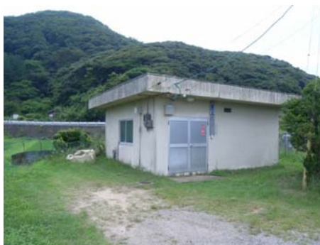
陸上水源（機械室、薬品室）
