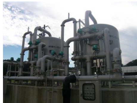
恩志水源（除マンガン施設）
