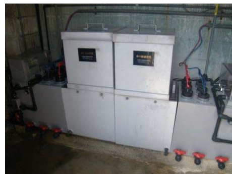
陸上水源（生成次亜注入装置）
