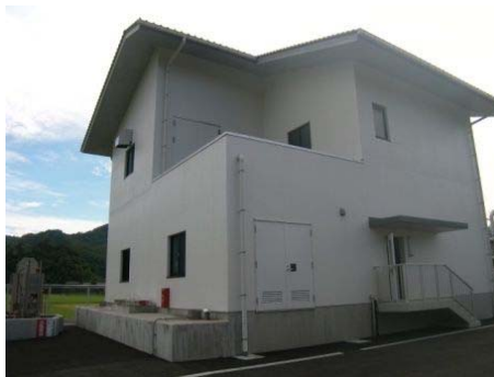
恩志水源（ポンプ室、浄水池、薬品室等）
