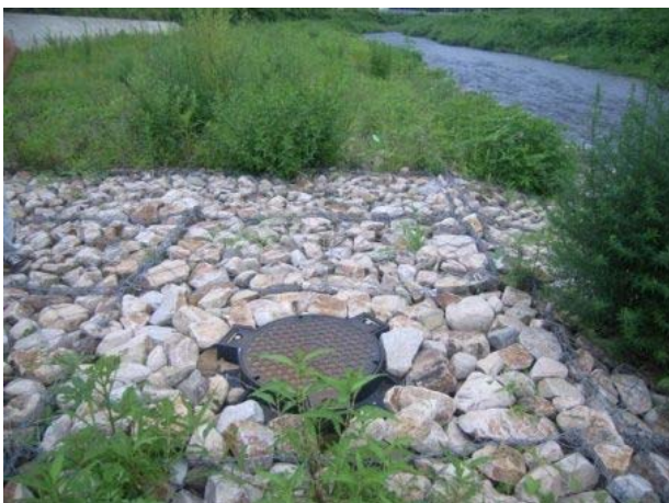
恩志水源（接合井、集水管）
