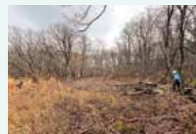
伐採作業の様子
