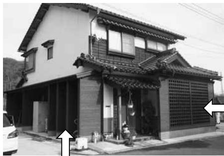
施工後 耐力壁
