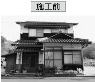
施工前 建物の周囲に面格子と耐力壁を設け、地震の揺れに強くなっています。
