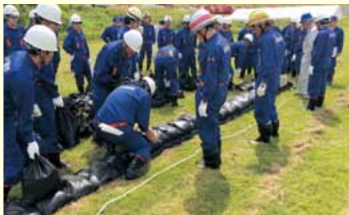
積み土のう工
